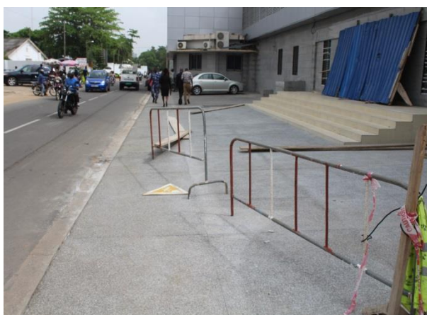
Façade rue de la caisse principale. (Travaux en cours)
