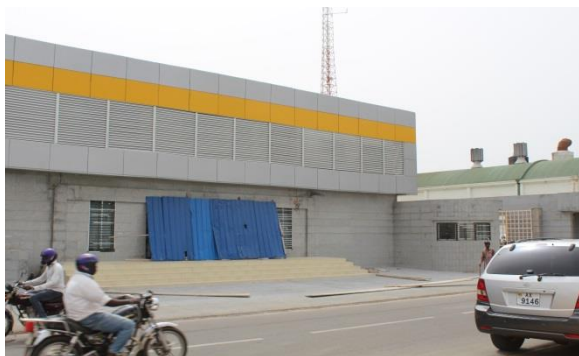
Façade rue de la caisse principale. (Travaux en cours)
