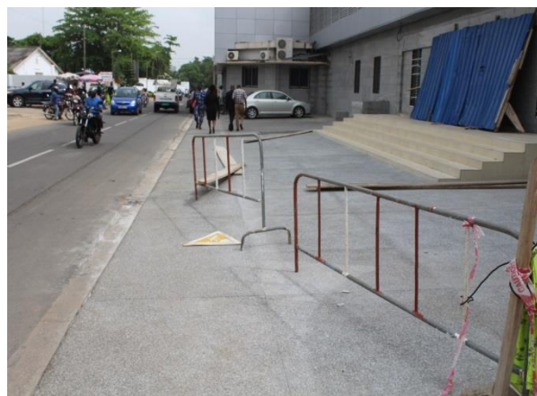
Vue entrée principale : Travaux de reprise de revêtement sol achevés
