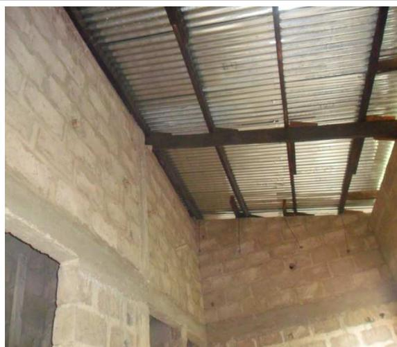
**Photo 3:** tôle sur charpente en bois d'une villa
