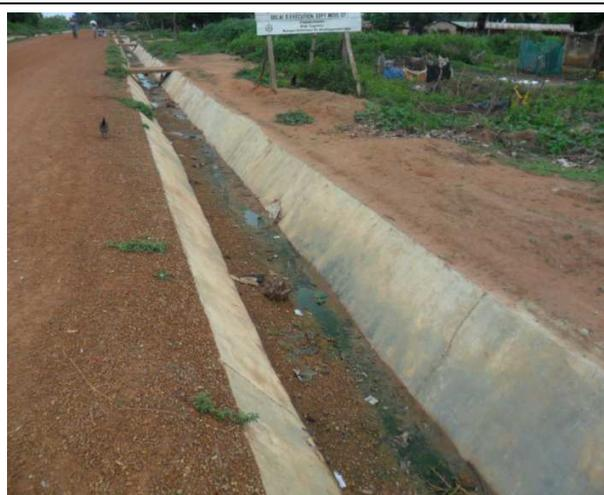
**Photo 1:** fossé latéral trapézoïdal en béton
