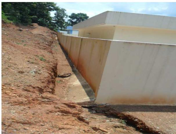
**Photo 1:** érosion a la base de la fondation de la clôture de l'Agence de la TdE
