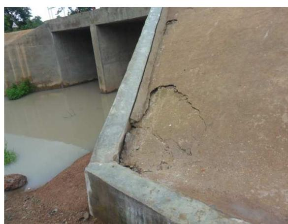
**Photo 4:** fissuration et affaissement du revêtement en béton au droit d'un mur en retour
