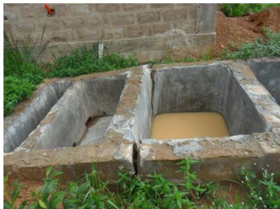
**Photo 5:** Fissuration des murs d'une fosse sceptique
