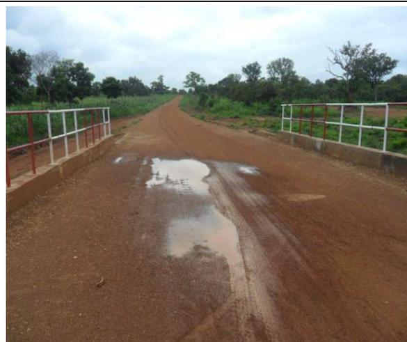
**Photo 2:** stagnation d'eau sur le tablier d'un dalot 3x4x4
