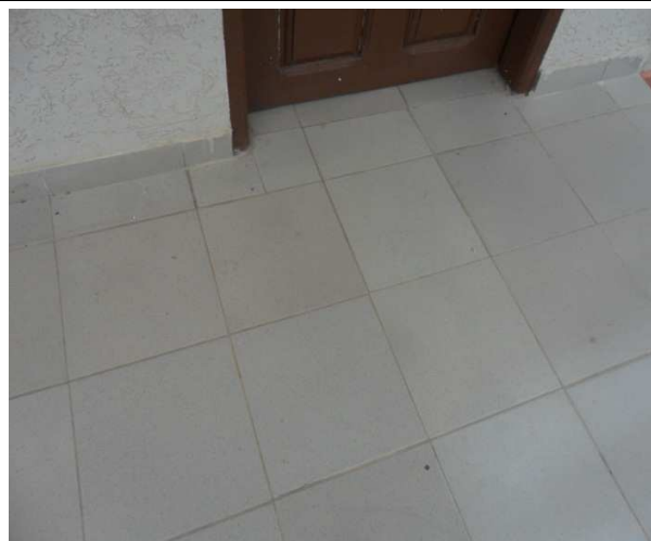
Photo 6: revêtement au sol en carreaux grès cérame
