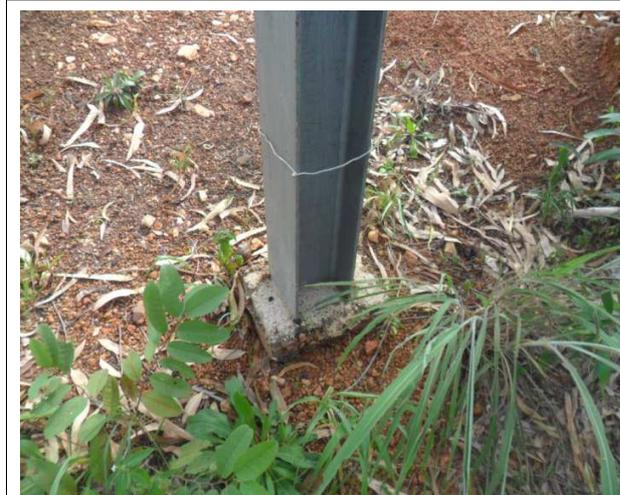
**Photo 3:** socle de fixation de poteau sapin au sol
