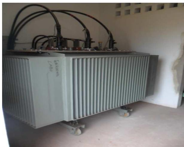
**Photo 3:** poste de transformateur H59 400 kVA
