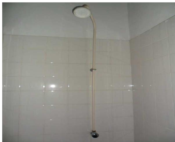
**Photo 4:** colonne de douche en tuyau flexible PVC
