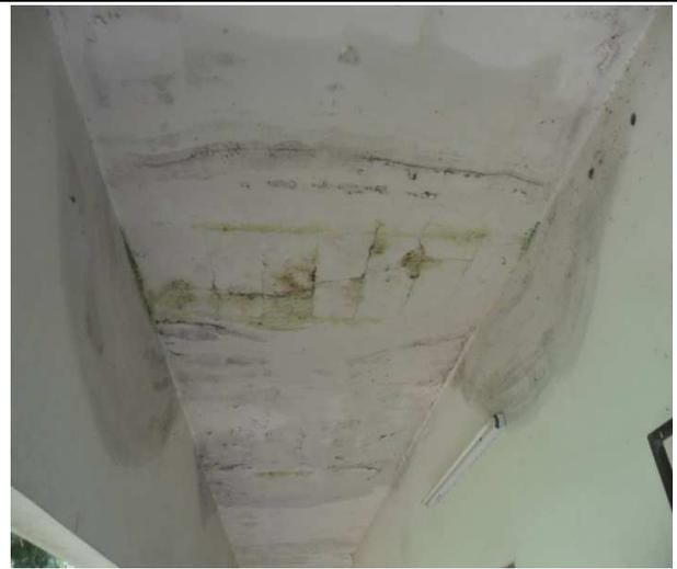
**Photo 4:** infiltration d'eau à travers la dalle du RDC
