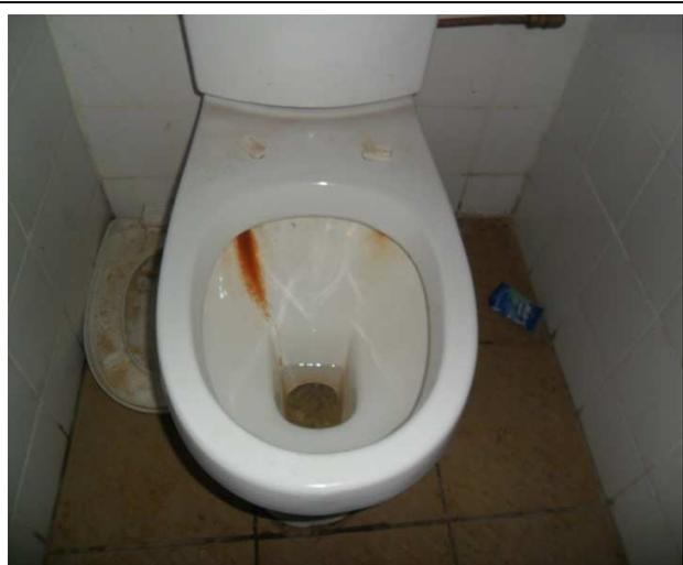
**Photo 1:** fond de pot de WC attaqué par la rouille
