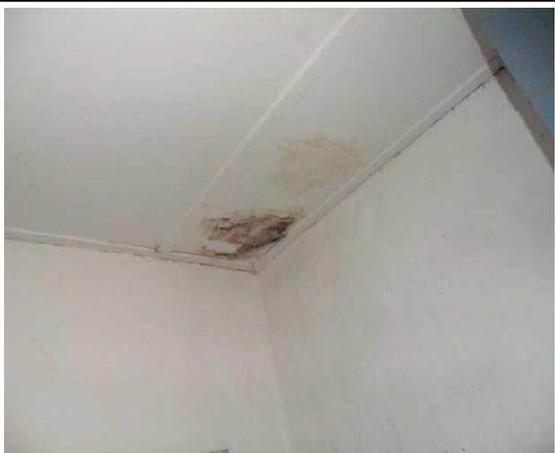
**Photo 5:** plafond mouillé par les infiltrations d'eau provenant de la toiture
