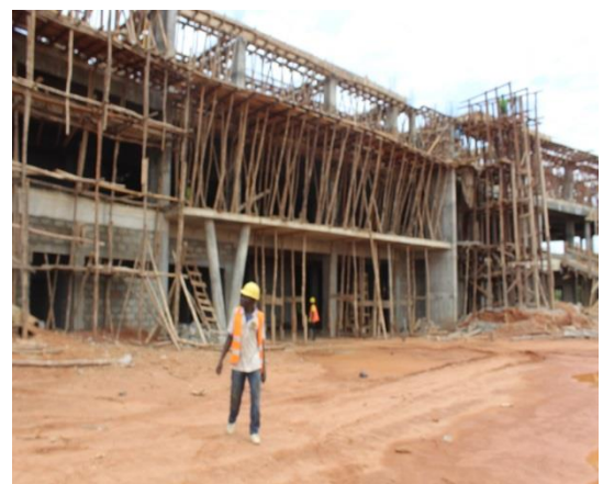
Travaux en cours avec un retard considérable
