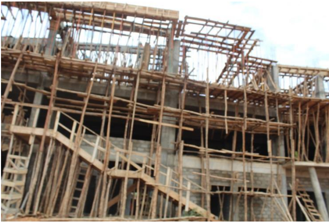
Façade principale : travaux en cours avec un retard considérable
