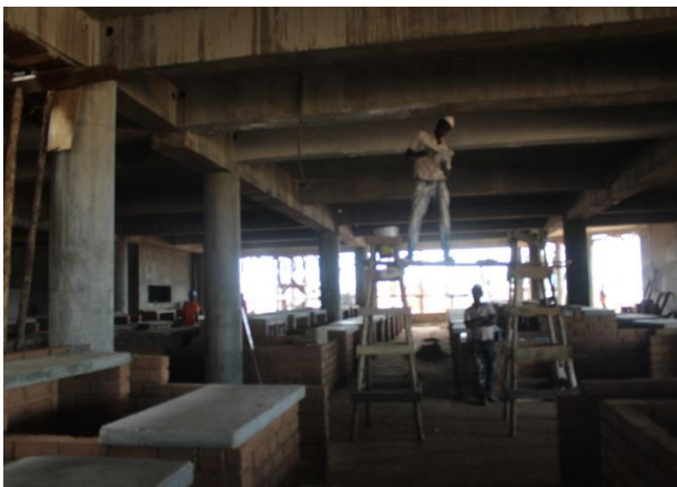
Ragréages des poutres
