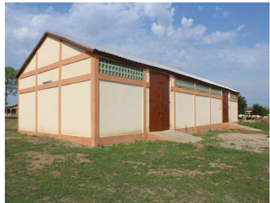
Vue d'ensemble du bâtiment (côté Sud-Ouest)
