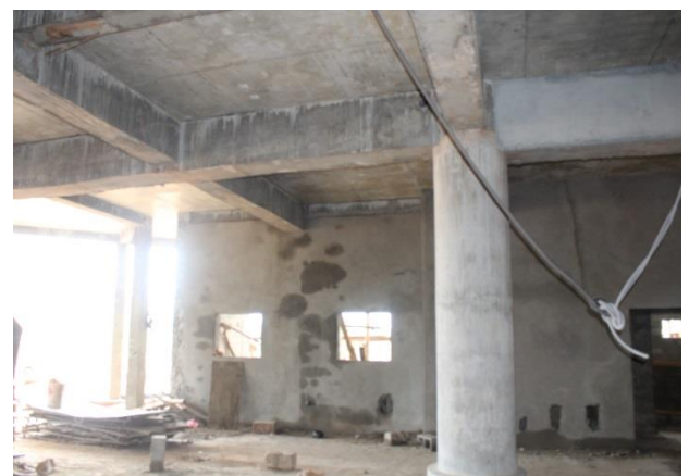
Coffrage et coulage du béton à soigner
