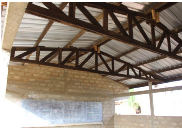
Vue intérieure d'une classe : Charpente bois et couverture en bac alu
