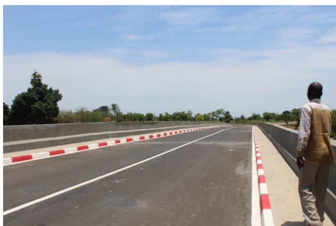
Sur le tablier du pont
