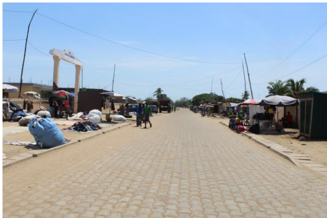
Voie en pavé pour accès au marché
