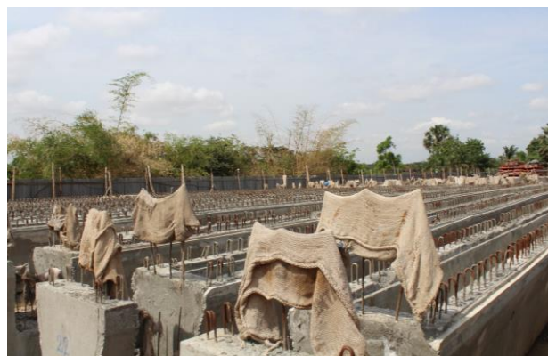
Poutres prêtes pour être posées
