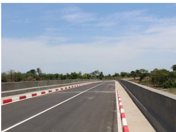
Sur le tablier du pont
