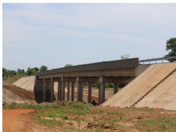
Vue de dessous du pont
