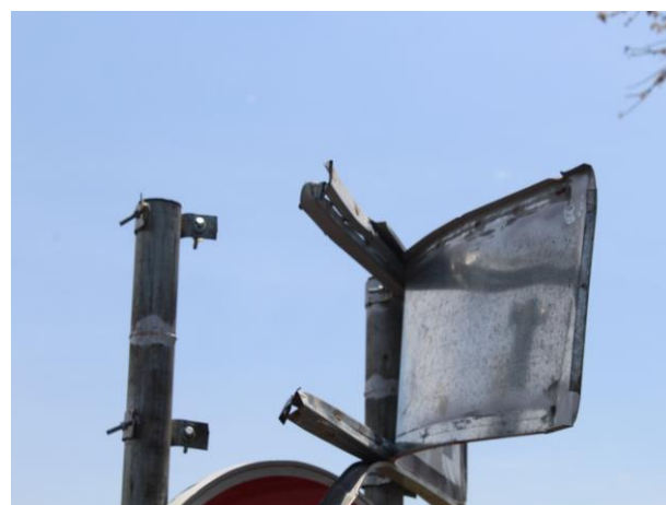
Les signalisations verticales endommagées par les usagers de route
