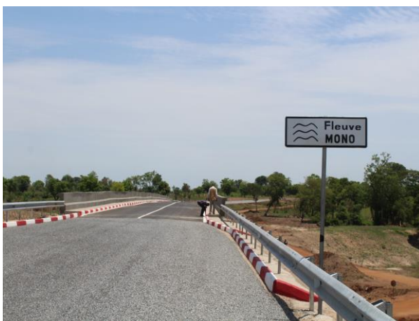
Sur le tablier du pont
