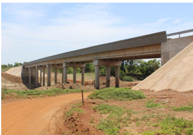
Vue d'ensemble du pont
