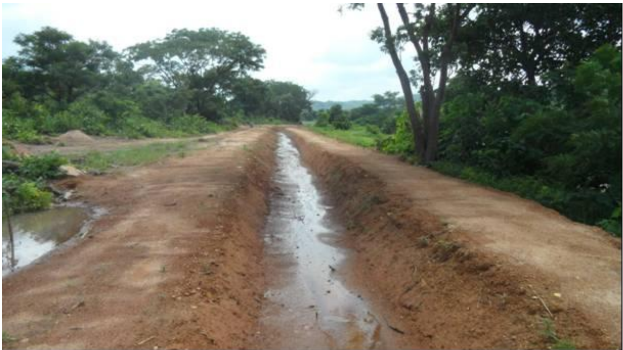
Site de Sara-Canal en terre au flanc de la montagne, peu résistant
