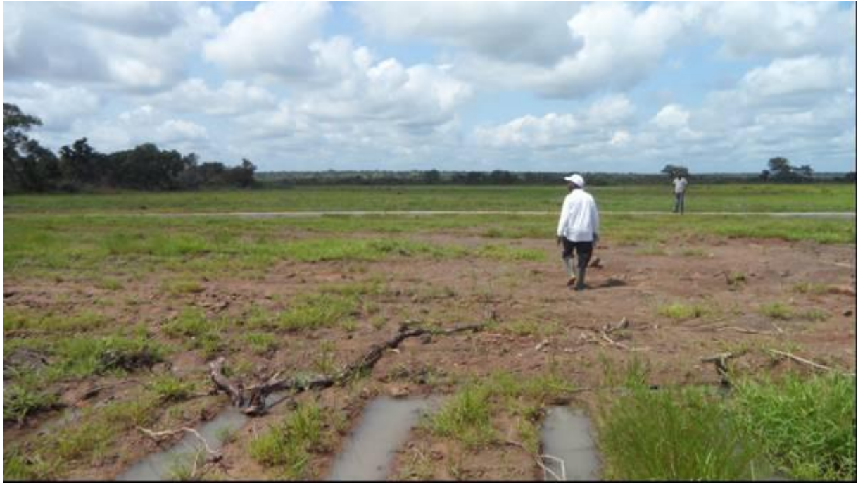
Présence appréciable et par endroit de racines en terrains de labour sous solage terminé
