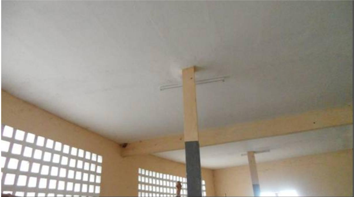
*Noter en partant du poteau pour la gauche de la photo la poutre noyée dans la dalle projetée sur le claustra*
