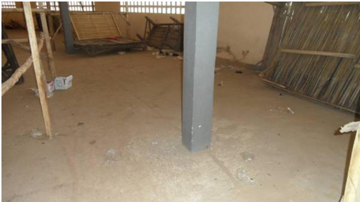
*Noter l'exécution de poteaux avec sa fondation en béton récemment coulé*
