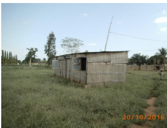
Les installations de chantier toujours sur la cours de l'école EPP Davié-Tékpo
