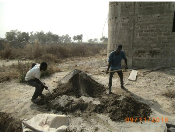
Travaux en cours
