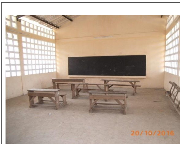
Intérieur d'une salle de classe EPP Kouvé-Badougbe
