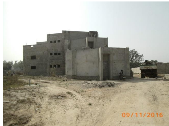
Vue d'ensemble du bâtiment
