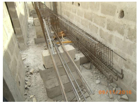
Travaux en cours
