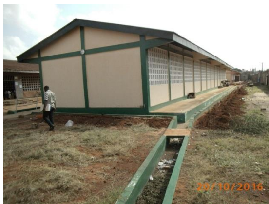
Etat de la rigole de drainage des eaux pluviales Tokoin Est
