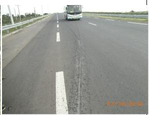
La couche de roulement endommagée sur 100m par un véhicule en surcharge au PK 2+420 (Environ 1cm de profondeur).
