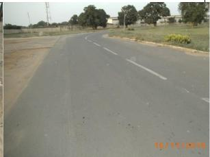
Voirie revêtue interne de la direction des transports Routiers et Ferroviaires + voie d'accès à la SAFER. Travaux exécutés : point à temps + surfaçage par revêtement.
