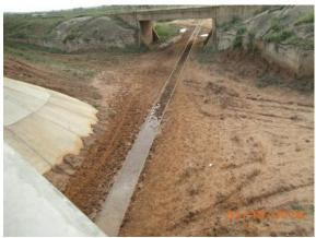
La remontée de la nappe phréatique inonde les rails du côté Est au PK 2+260 (Pont viaduc / passage de train).
