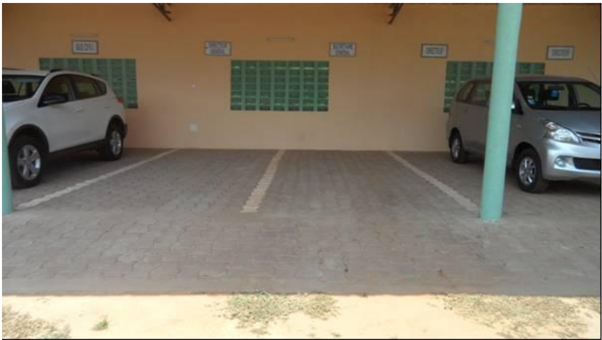
Poteaux en béton, preuve que la variante n'est pas exécutée
