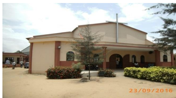
Vue d'ensemble du bâtiment
