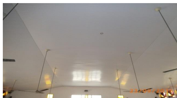
Plafond exécuté en PVC
