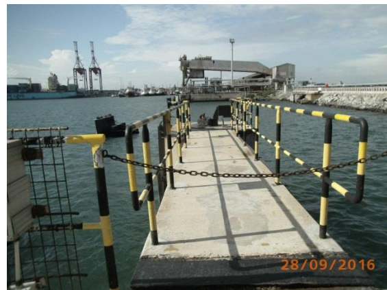
Cabestan N°3 démonté
