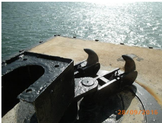
Cabestan N°2 démonté (vue de profil)
