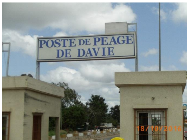
Vue du poste de péage de DAVIE
