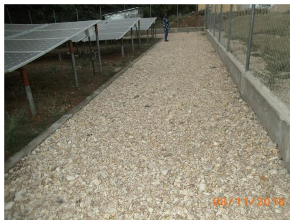
Protection autour du champ de panneaux (SOTOUBOUA)
