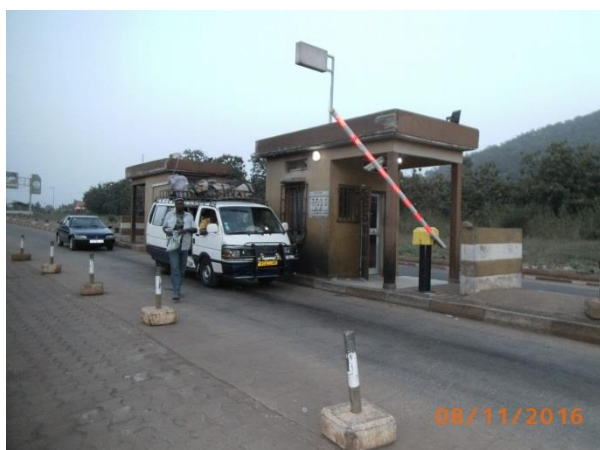
Vue du poste de péage de SOTOUBOUA
