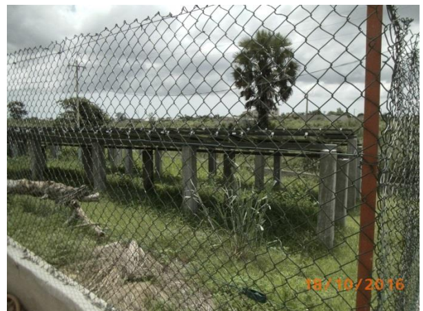
Vue du champ de panneaux solaires de SANGUERA
