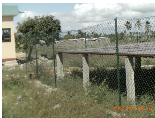
Vue du champ de panneaux solaires de VODOUGBE
