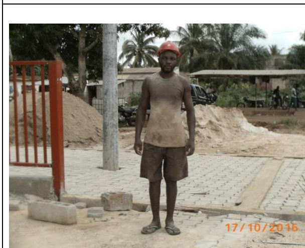
Vue d'un ouvrier sans l'équipement de protection individuel (EPI)
