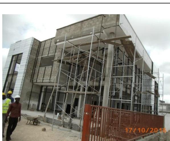
Travaux de vitrerie en cours
