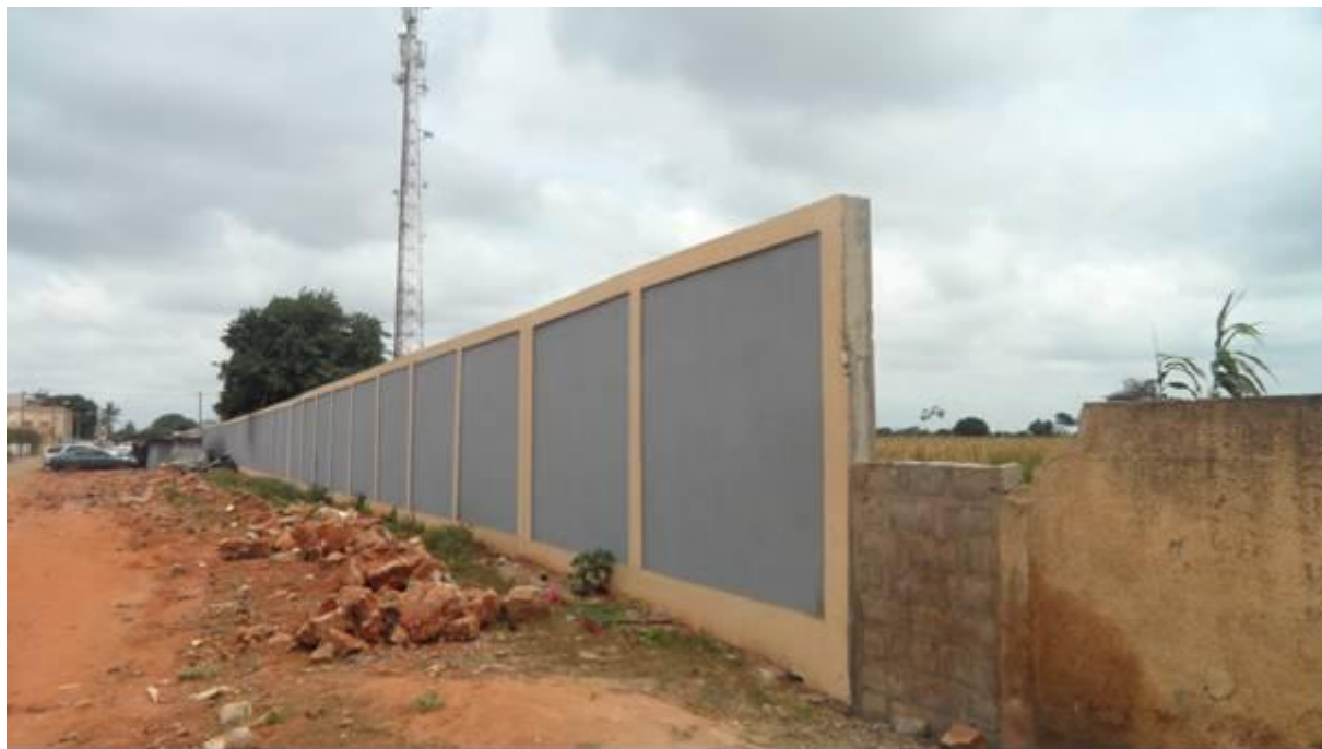
Noter les produits de démolition laissés sous forme de gravas en vrac
