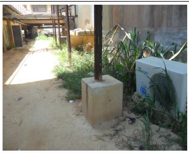
**Photo 2**: massif de support au sol recevant un rail
