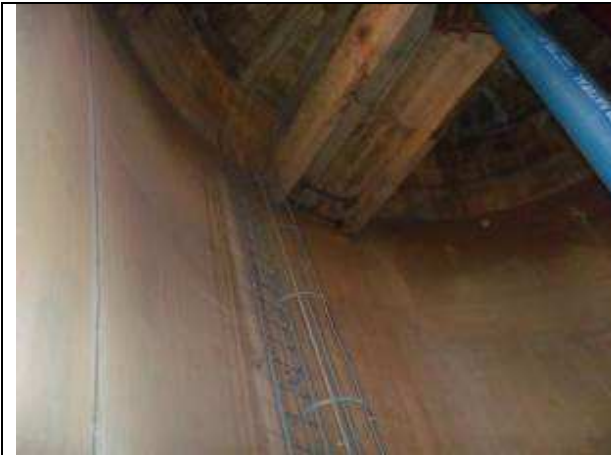
Photo 5 : colmatage des fissures à l'intérieur du château d'eau de l'université de Lomé
