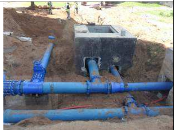
Photo 8 : pose de conduites d'arrivée et de vidange du château de Bè
