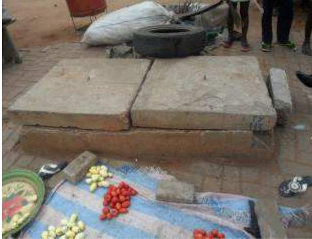
**Photo 1** : Dallette de couverture d'un regard sous trottoir au carrefour Pharmacie Léo
