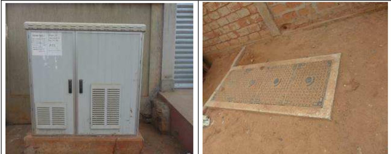
**Photo 3** : coffret d'arrivée de câbles fibre optique
